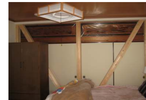
内面から筋交いが見えて安心感がある
