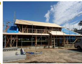
一部解体撤去・移動・増築
