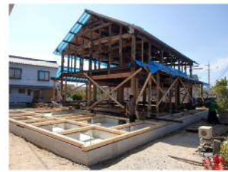
新設基礎に移設
