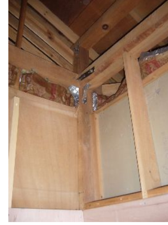
柱頭・柱脚金物補強
