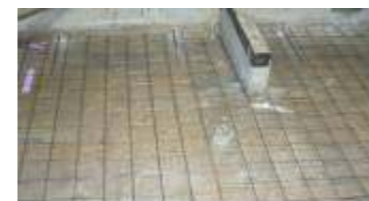
床下シート防水 ネット鉄筋
