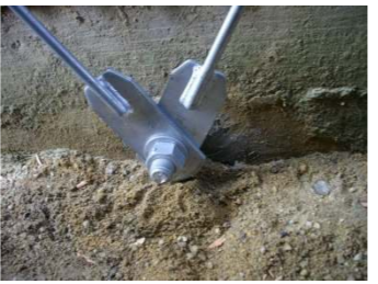
・基礎取付け部
