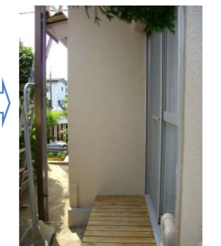
・モルタル、塗装にて完了
