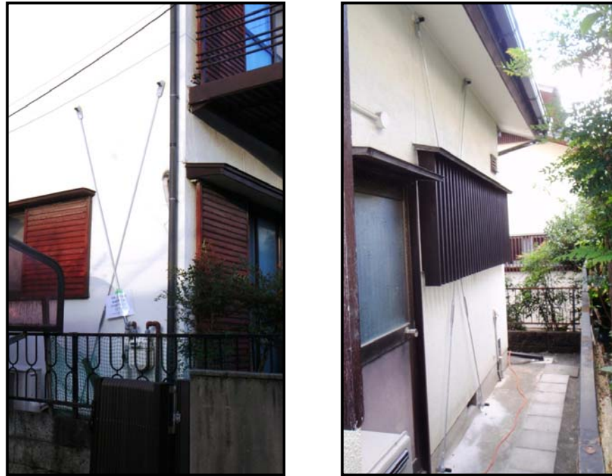
アイワン工法による外部補強
