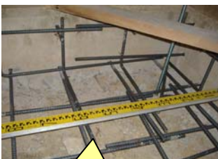
鉄筋配筋 基礎補強
