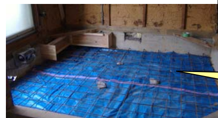
鉄筋配筋 基礎補強
