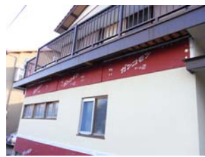
ガンコモンG1 施工
