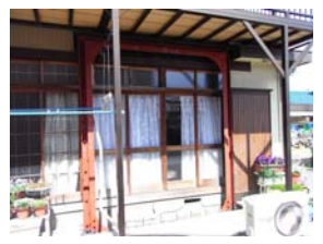
ガンコモンG2 施工
