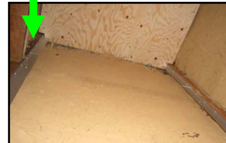
下屋天井を構造用合板で補強
