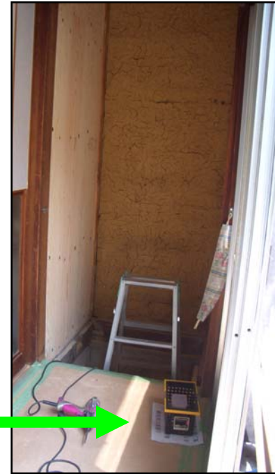
部分開口 構造用合板工法「真壁上下あき」を 押し入れ内の補強で利用
