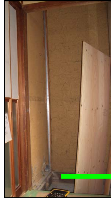
部分開口 構造用合板工法「真壁上下あき」を 押し入れ内の補強で利用
