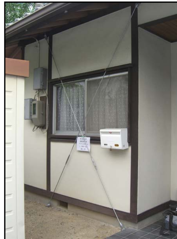
アイワン工法による外部補強
