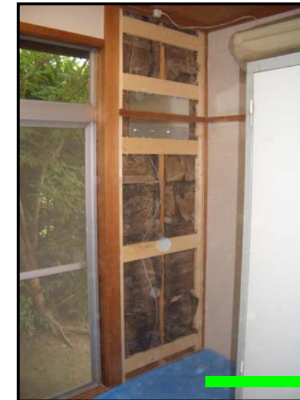
ガーディアンウォール工法による補強
