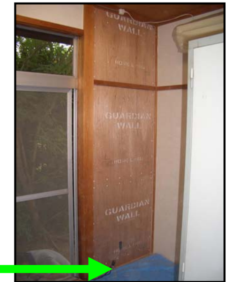
ガーディアンウォール工法による補強
