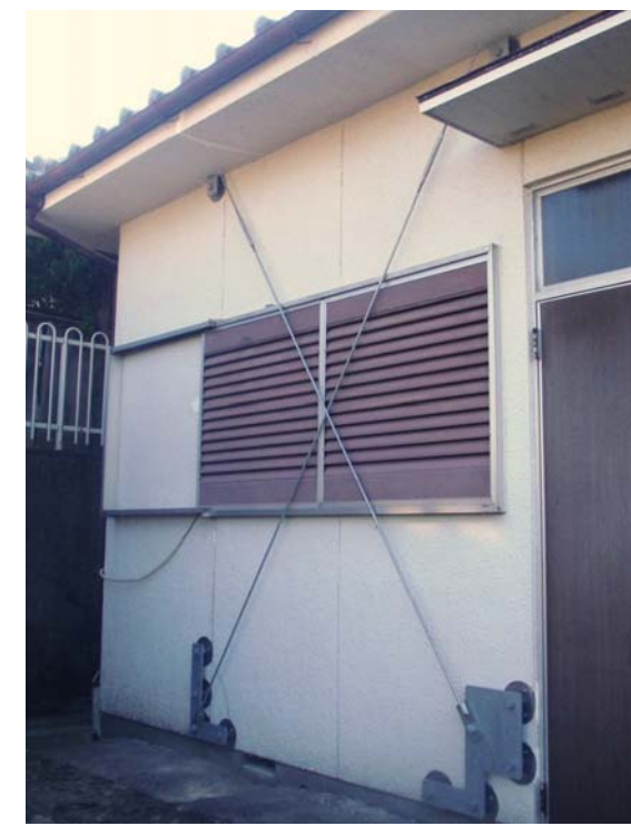
北面 ウッドピタブレース補強(一間タイプ)
