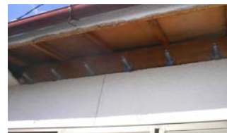
ウッドピタアンカー取り付け
