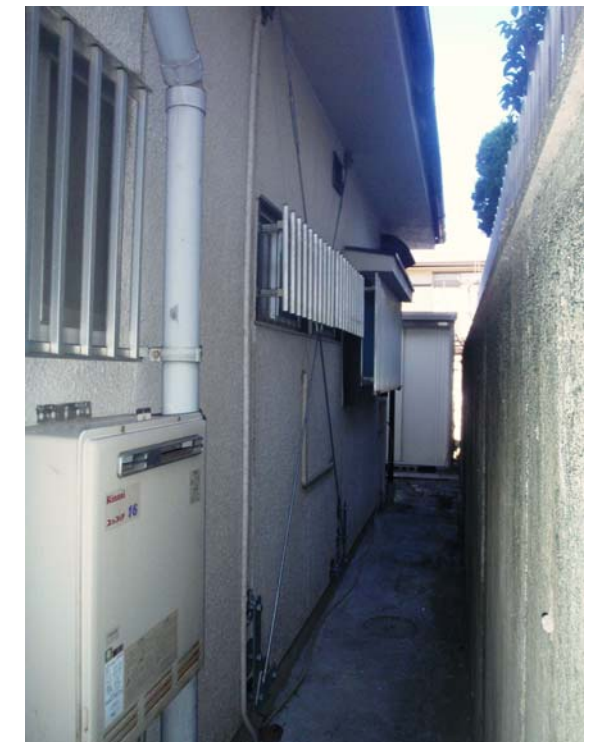
東面 ウッドピタブレース補強(一間タイプ)
