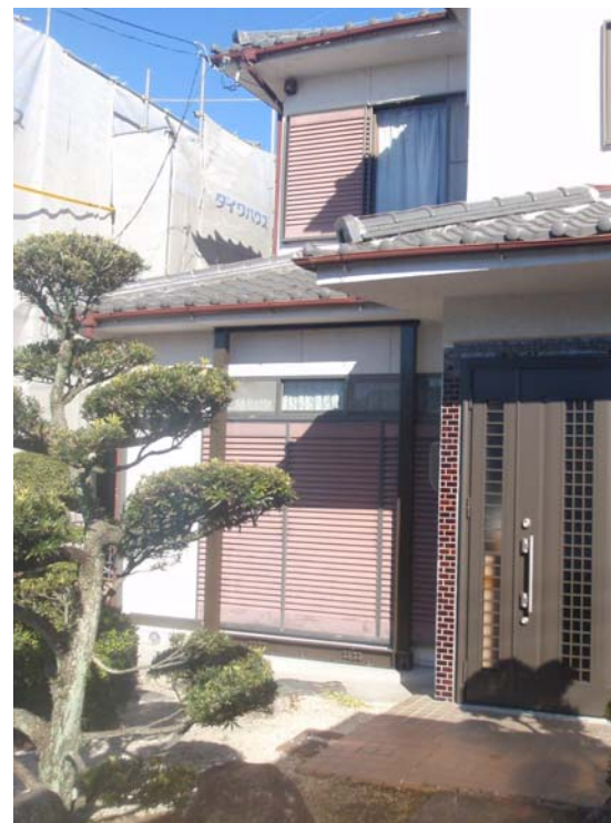
南面 ウッドピタフレーム補強
