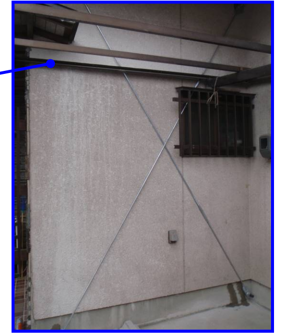
外付けブレース工法 アイワン
