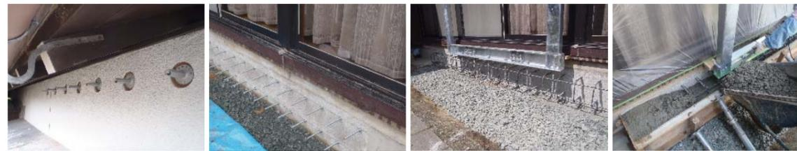
ウッドピタアンカー設置    ウエッジ式アンカー設置    打増し基礎配筋 鉄骨フレーム取付け    打増し基礎コンクリート打設
