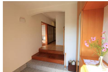
耐力壁を増設した玄関と廊下廻り
