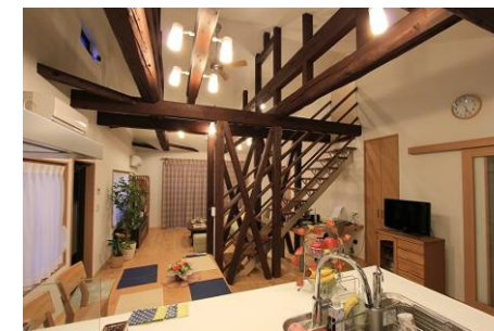
構造を表しにして意匠的にした耐震補強
