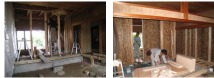
間取りの変更に伴う耐力壁の増設
