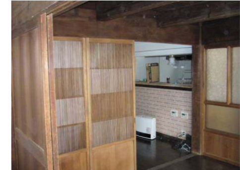
既存材料を有効利用した建具
