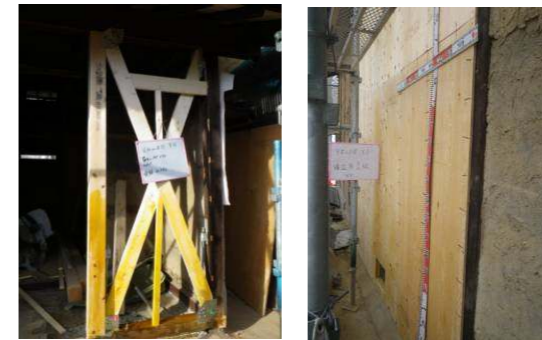
壁材に筋交 面材を利用
