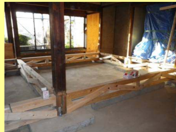
土台と床梁の間にトラス組
