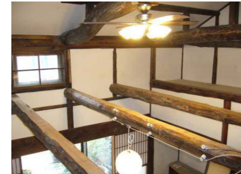
漆喰塗りの壁
