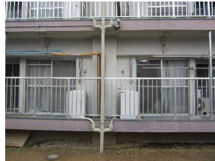
写真 2: 補強体を外側から取り付けるため、使用勝手が変わりません。
