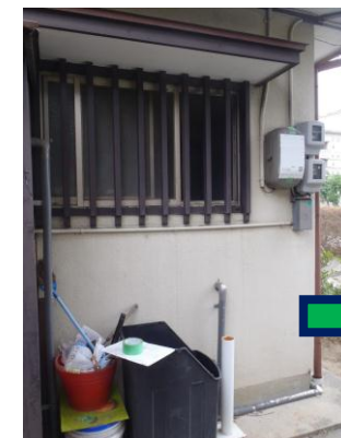
在来工法 瓦葺き壁土有、外壁モルタル塗
