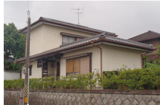
在来工法 瓦葺き壁土有、外壁モルタル塗
