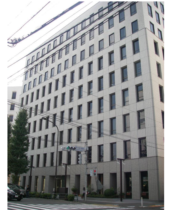
改修後全景: 建物の美観を損ないません
