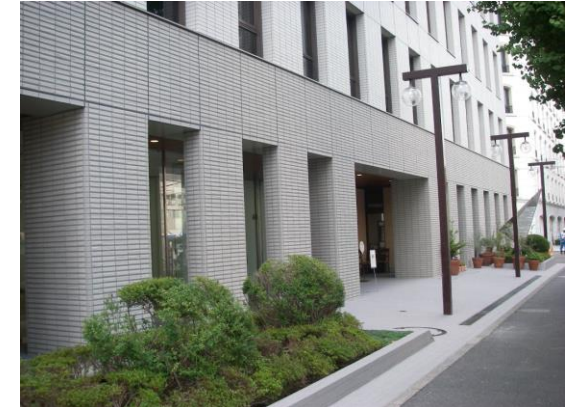
改修後エントランス: 既設に合わせてタイル仕上げ
