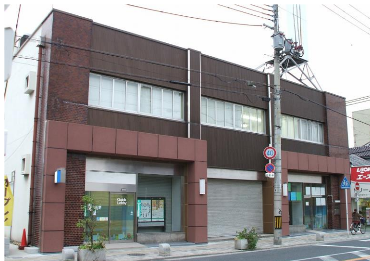
改修後全景: 建物の美観を損ねません
