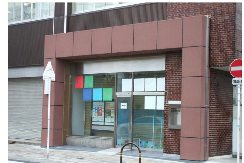
改修後エントランス: 改修後も出入口の大きさを確保 愛知建築地震災害軽減システム研究協議会
