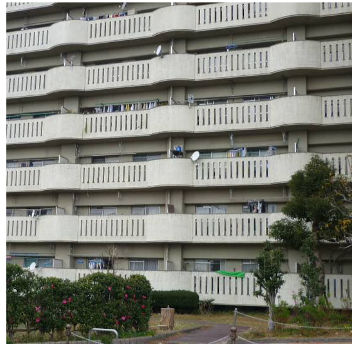
改修前建物南面
