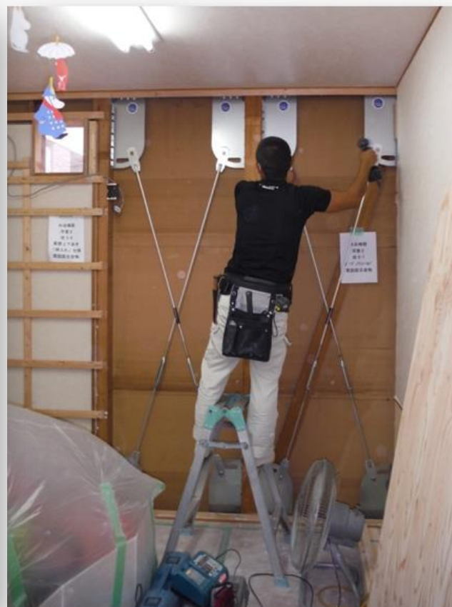
天井・床を壊さない筋交補強 ガーディアンシールド
