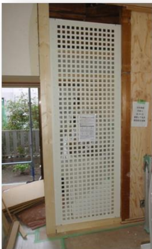
光と風を通す壁で耐力壁新設 パンチくん
