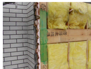
一部外壁を剥がして「柱-梁」接合部を補強
