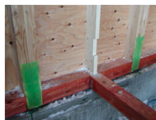
内部の壁・床を剥がして内側から「柱-土台」接合部を補強
