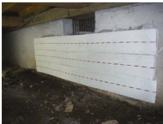
通気孔付近補強
