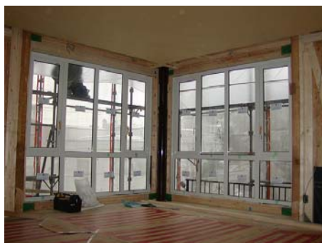
出隅開口部耐震補強
