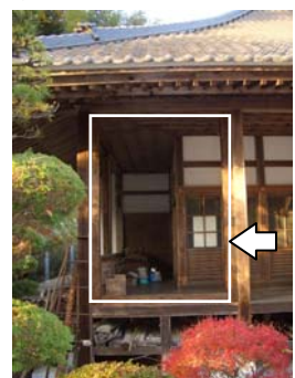
寺院耐震改修
