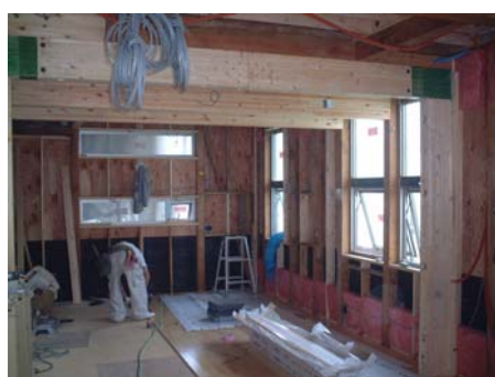
間仕切壁撤去震補強
