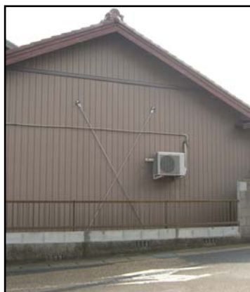
トタン外壁への取付け
