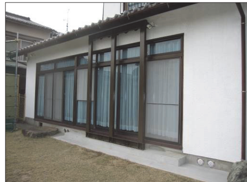
列柱タイプ設置状況
