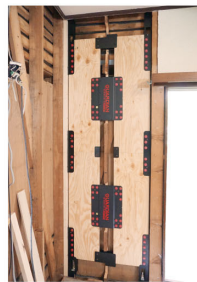
制振壁設置例
