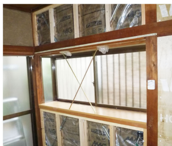
窓開口の補強例
