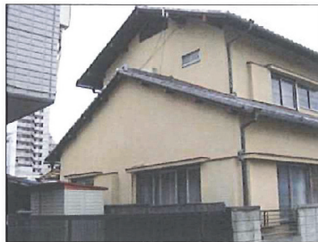
2.施工箇所現況
