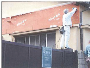
3.モルタル外壁の上 からコーチボルト で繋結
