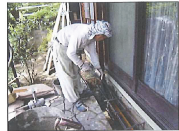
6. コンクリート打設
