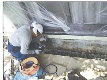
3. あと施工アンカー 掘削孔
