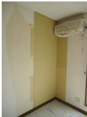
* 石膏ボードの復旧
