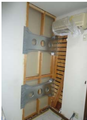
* NS木造耐震デバイスを取り付け
